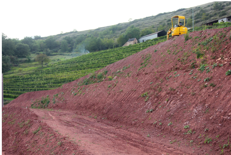
Travaux de terrassement au domaine du Cros
